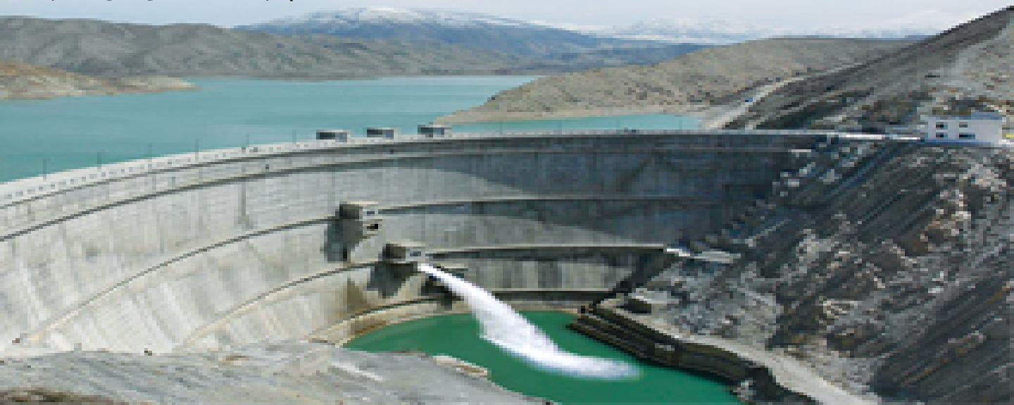
پروژه سد مخزنی بتنی شیروان
